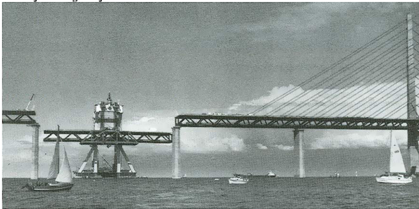
Ugradnja nosača pomoću ploveće dizalice Svan
