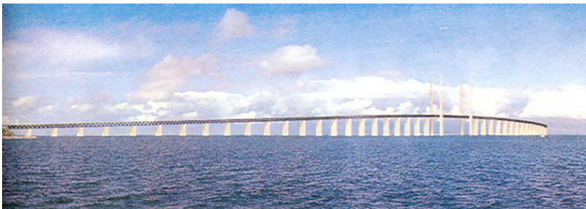
Pogled na most
