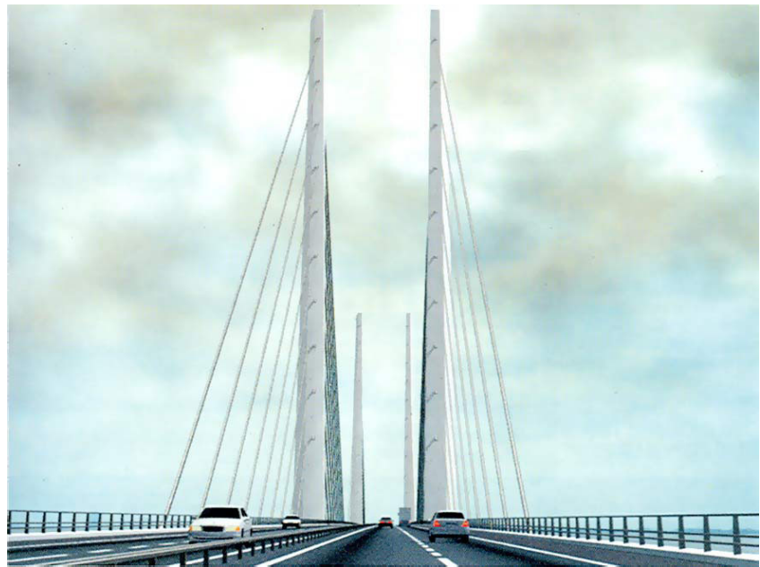
Pogled na pilone ovješnog mosta
