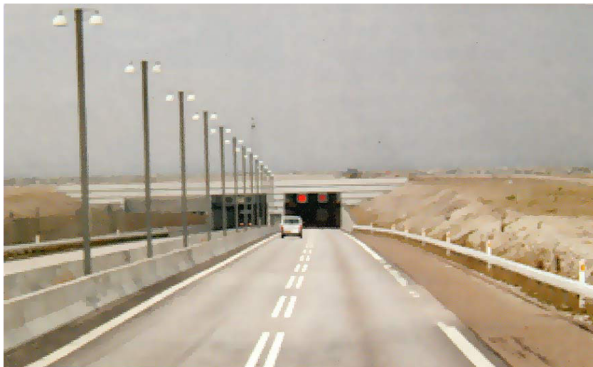
Ulaz u tunel pokraj Kopenhagena
