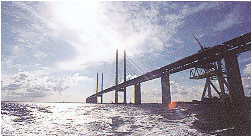
Most tijekom izgradnje
